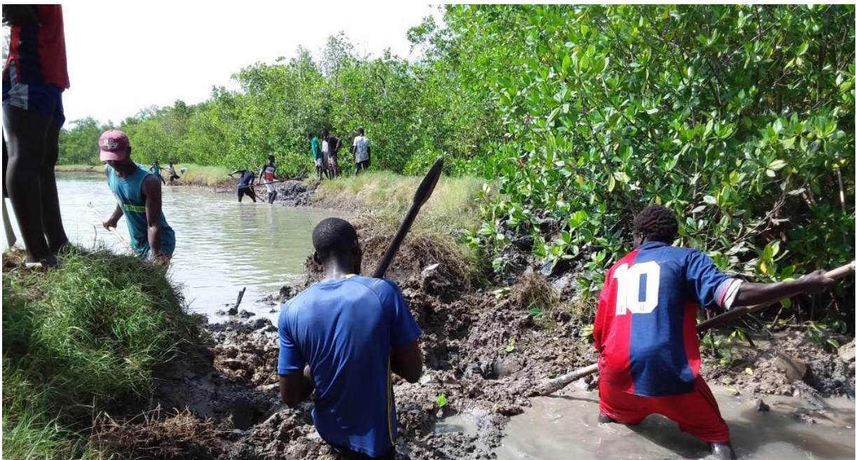
Ouverture des brèches pour la Régénération Naturelle Assistée
