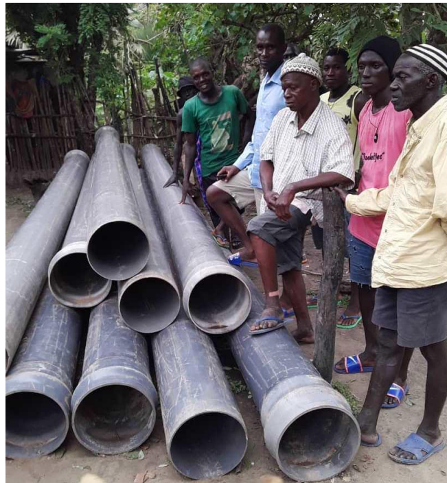
Fourniture de tubes de drainage pour les rizières du village de Caboxanque
