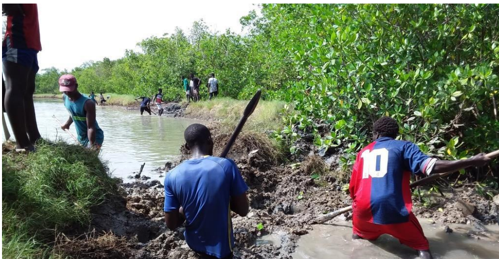
Foto. RNA: Abertura de brechas nos diques de cintura nas bolanhas abandonadas
