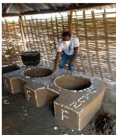
Foyer amélioré destiné à la cantine scolaire du village de Caboxanque
