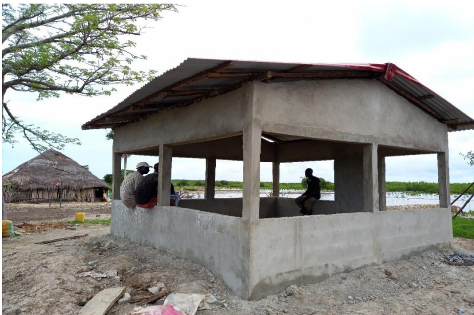
Hangar pour abriter la décortiqueuse, village de Djobel
