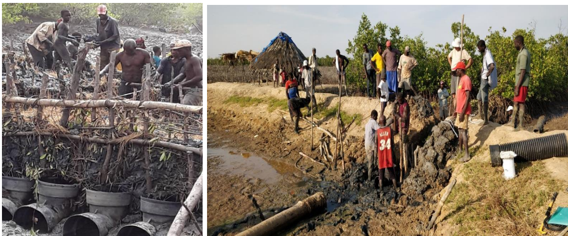
Instalação de estruturas em Caboxanque (esquerda) e Djobel (direita)
