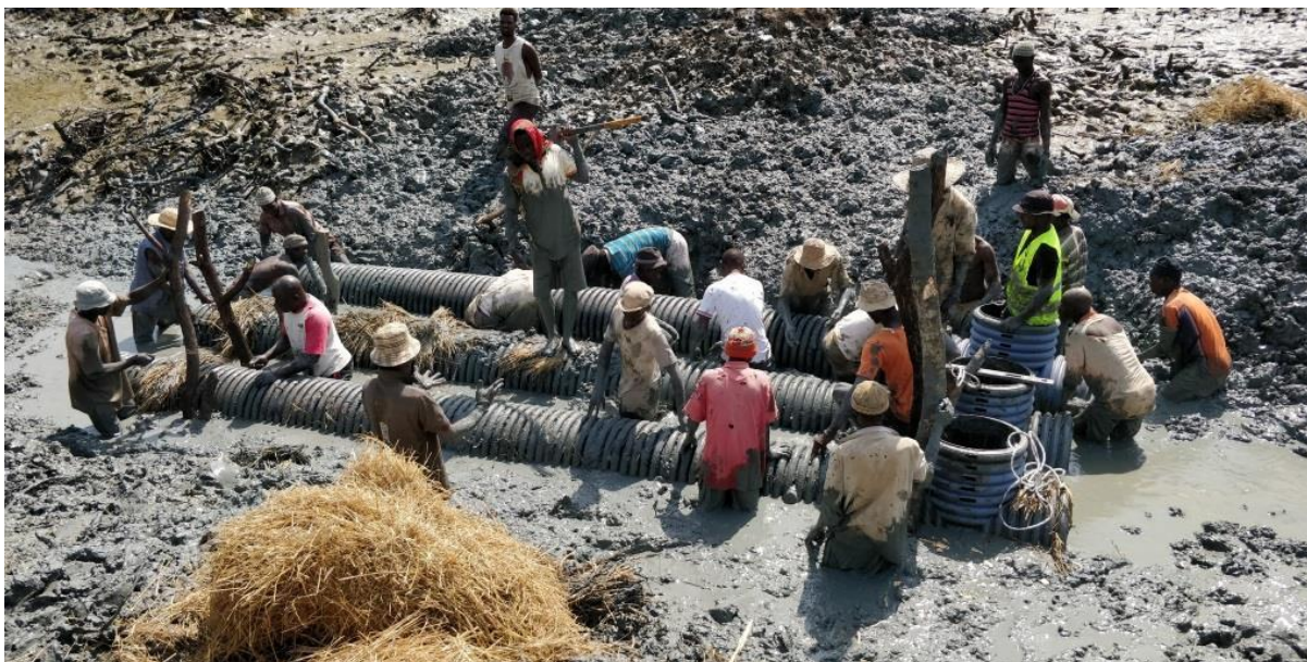
Colocação de tubos de 500 mm em arrozal em Binibaque durante visita de intercâmbio
