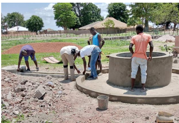
Construção de poços de água e vedação em Enxudé
