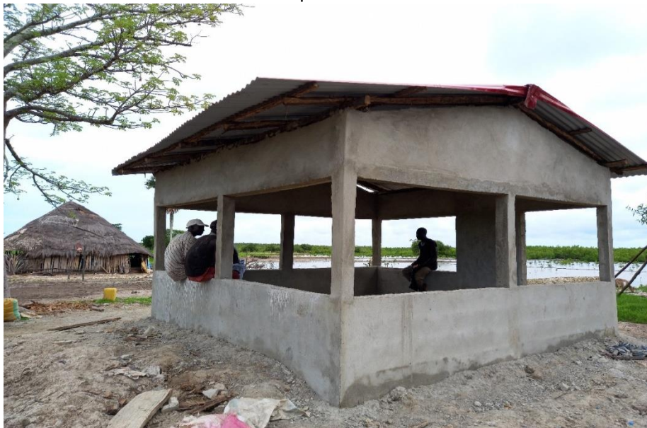
Foto: Hangar para descascadora de arroz, construído em Djobel
