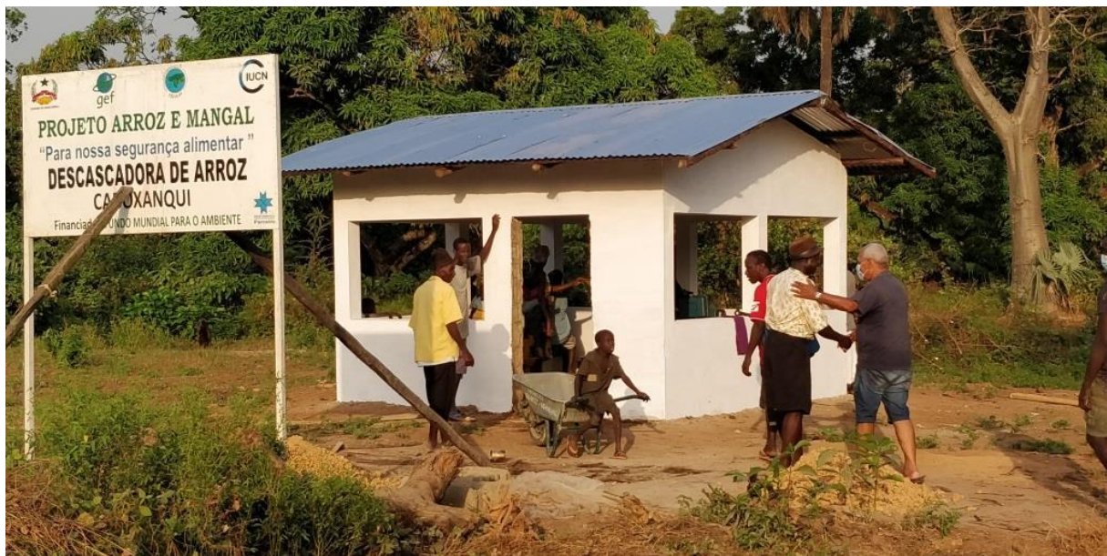
Hangar e descascador em Caboxanque
