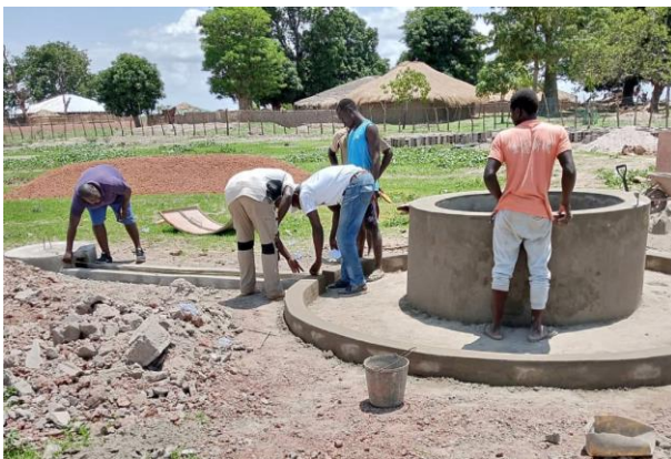
Construction du puits et de la clôture à Enxudé
