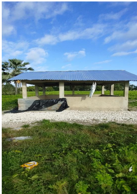
Elalab : Construction de abris de la décortiqueuse du riz
