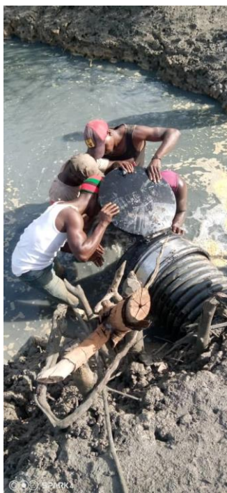
Installation d'un clapet de 500mm et de 200mm
