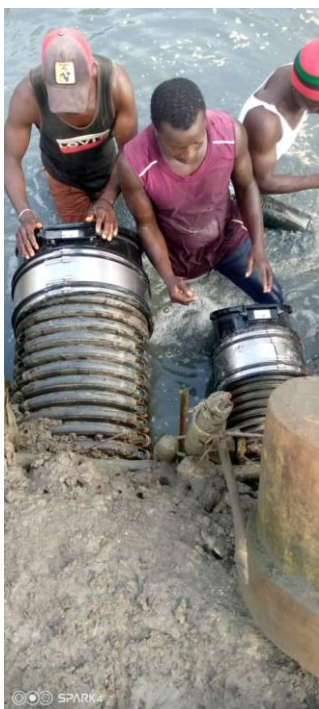
Installation d'un clapet de 500mm et de 200mm
