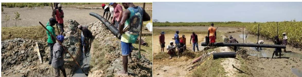
Colocação de tubos em bolanhas de Bolol
