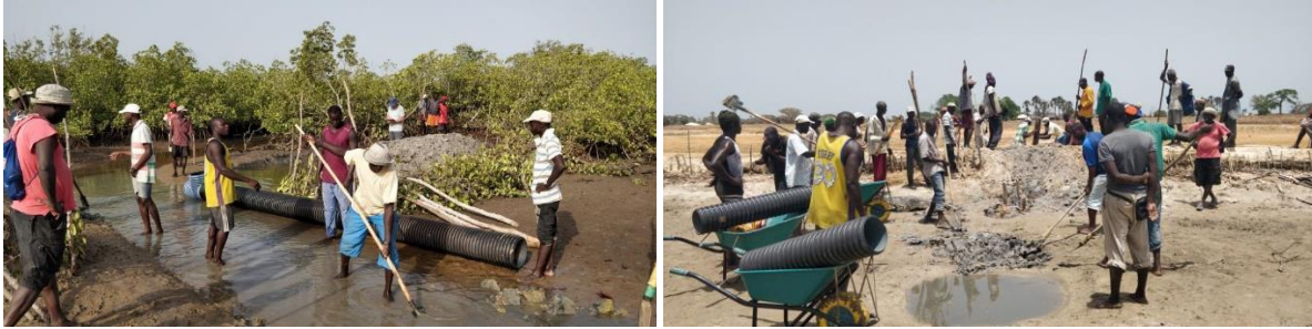
Colocação de tubos em Elia
