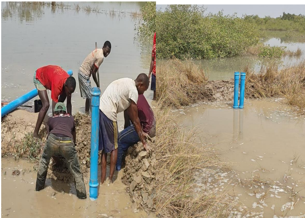
Cadique Nalu: formação-demonstração da instalação de tubos de 110 mm
