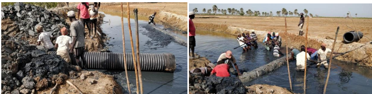
Djobel: Instalação dos tubos
