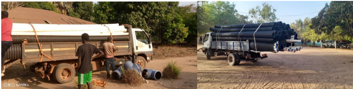
Transporte dos tubos de Bissau para as tabancas
