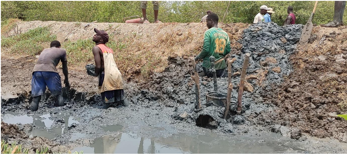
Caboxanque- Bolanha de Tsamba-Cia: 1 tubo e 1 Te de 300 mm
