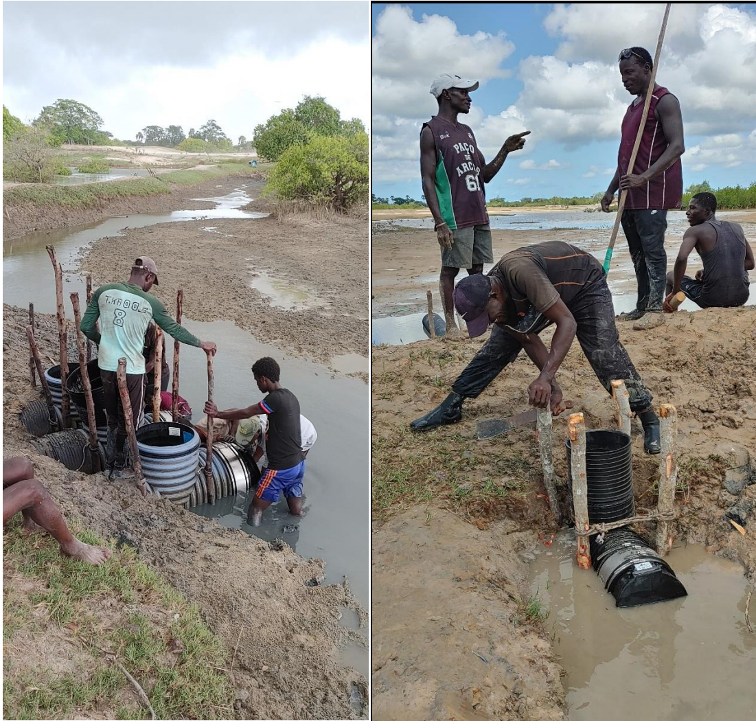
A esquerda: Essor, instalação de 6 válvulas de 500. A direita : Elia, instalação de 2 válvulas de 200
