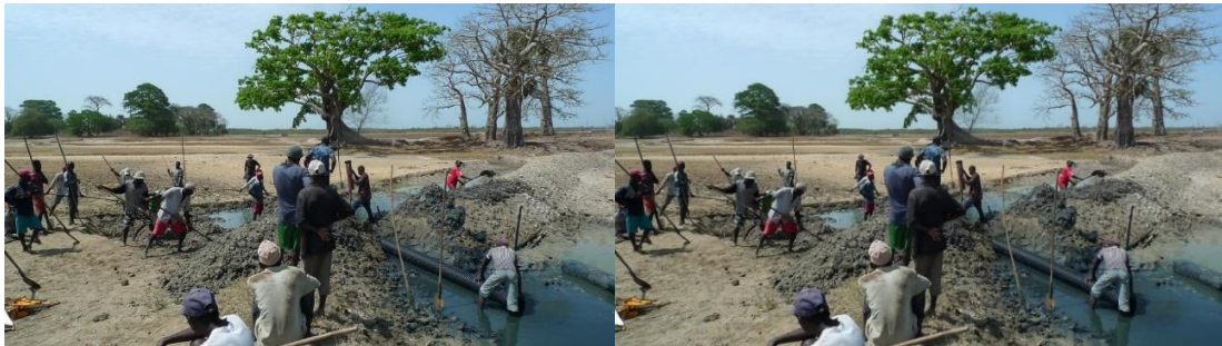
Elalab: Colocação de tubos na bolanha
