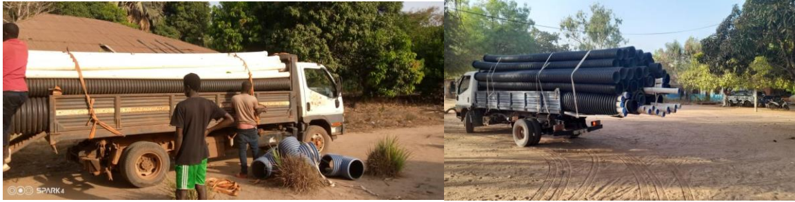
Transport des tubes depuis Bissau en direction des villages
