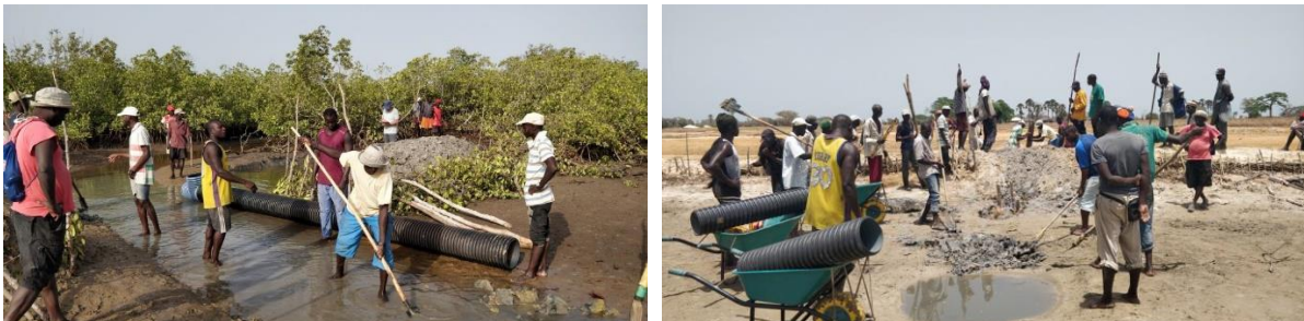
Pose de tubes à Elia
