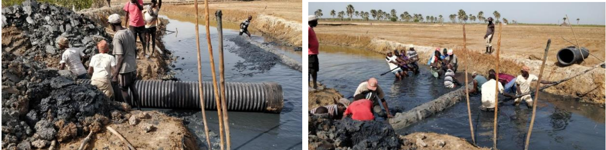
Pose des tubes à Djobel.
