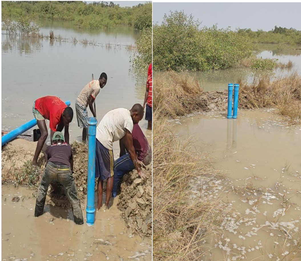
Cadique Nalu: formação-demonstração da instalação de tubos de 110 mm
