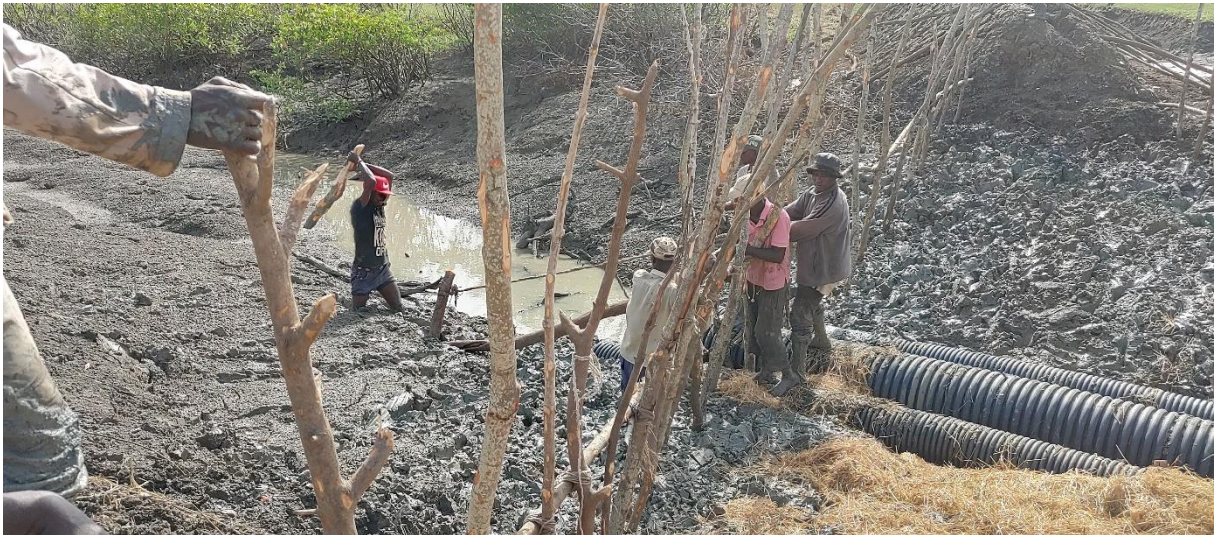
Djabada-Ilha de Nsuck: Construção da barragem tradicional com a participação dos produtores de Enxude: 1 tubo e 1 Te de 500 mm e 2 tubos e 2 Tes de 300 mm
