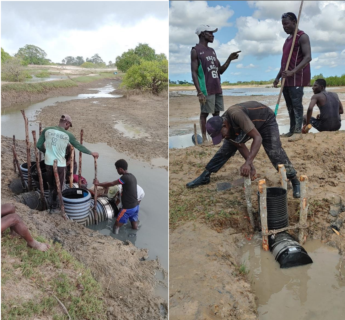
A gauche : Essor, installation de 6 clapets de 500. A droite : Elia, installation de 2 clapets de 200
