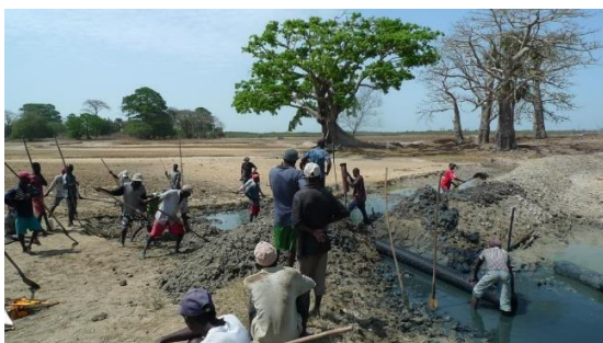
Pose des tubes à Elalab
