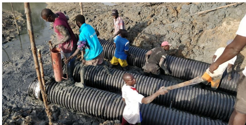
Les 3 tubes de 500 mm et leur clapet posés (village d'Eossor)
