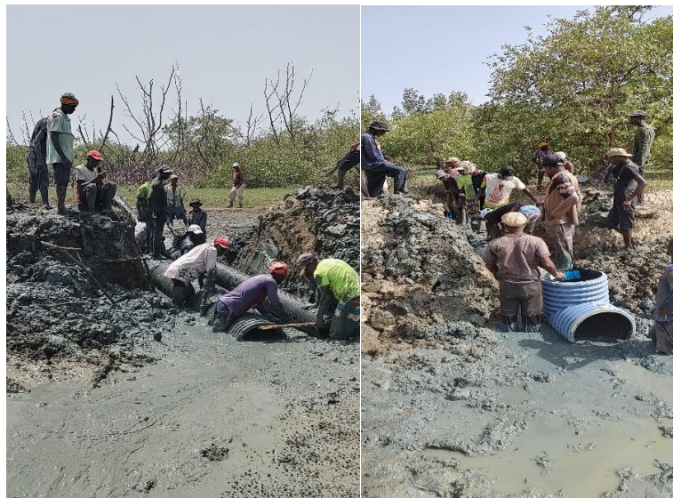
Enxude- Ilha do Sal : colocação de tubos: 1° sitio: 1 tubo + Te de 500 e 1 tubo +Te de 300mm; 2° sitio: 1 tubo + 1 Te de 500 mm
