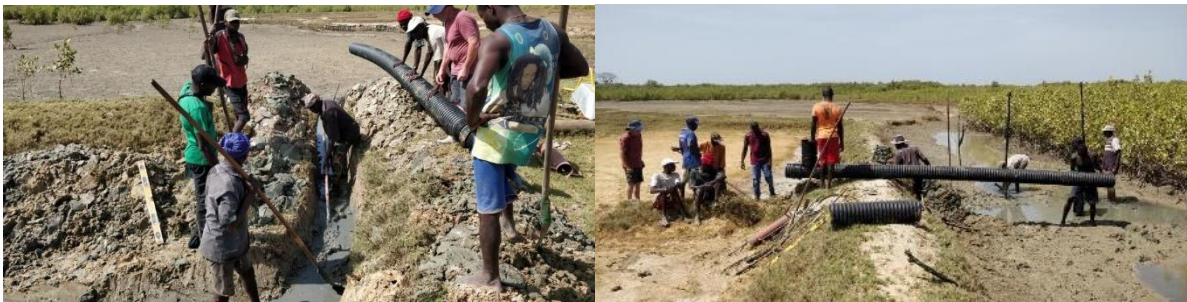
Pose de tubes dans les bolanhas de Bolol
